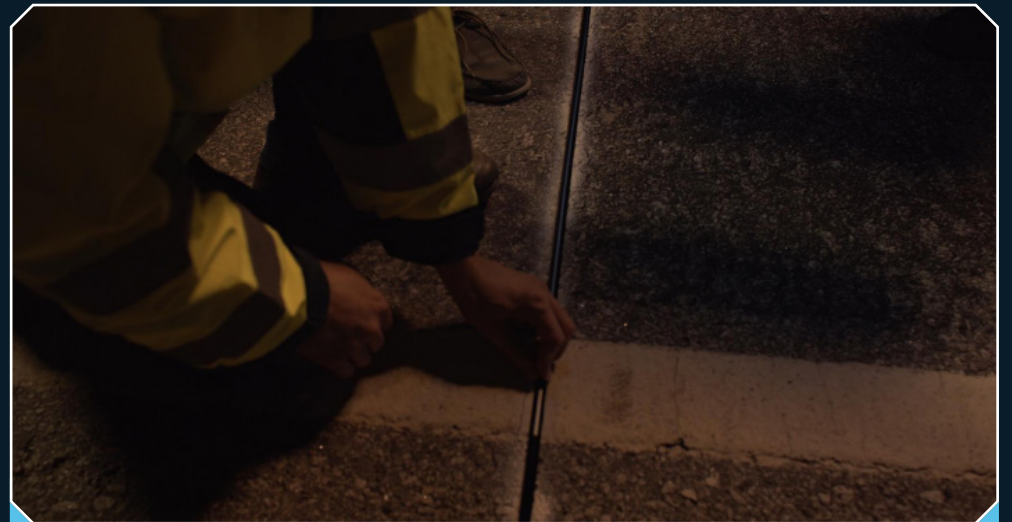
Instalação de sensores
